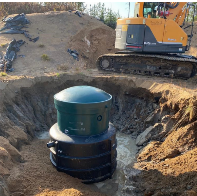
Vatten bundet till jordmassorna började rinna in i schaktet inom ca två timmar från öppnandet av schaktet. Grundvattennivån steg i samma takt som schaktet fylldes.
