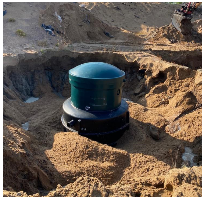
Vatten bundet till jordmassorna började rinna in i schaktet inom ca två timmar från öppnandet av schaktet. Grundvattennivån steg i samma takt som schaktet fylldes.
