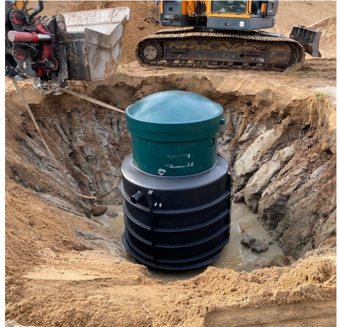
I takt med att schaktet fylldes började grundvatten stiga upp.
