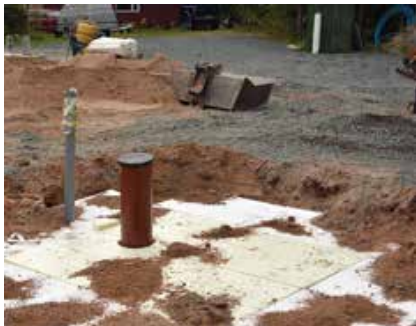
Eristä kaivanto ja viemäriputki routaeristelevyillä.
