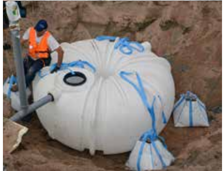
Ankkuroi umpisäiliö vähintään neljästä eri kohdasta.
